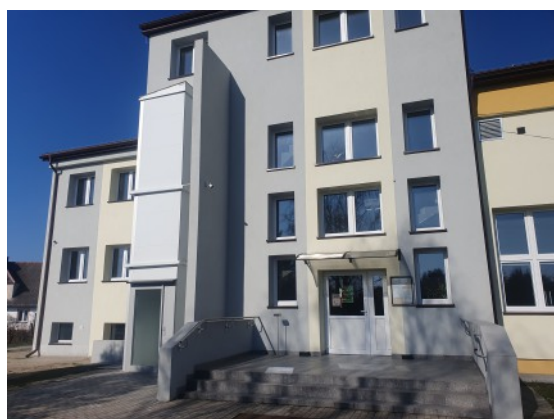
Termomodernizacja GOK - windy zewnętrzna
